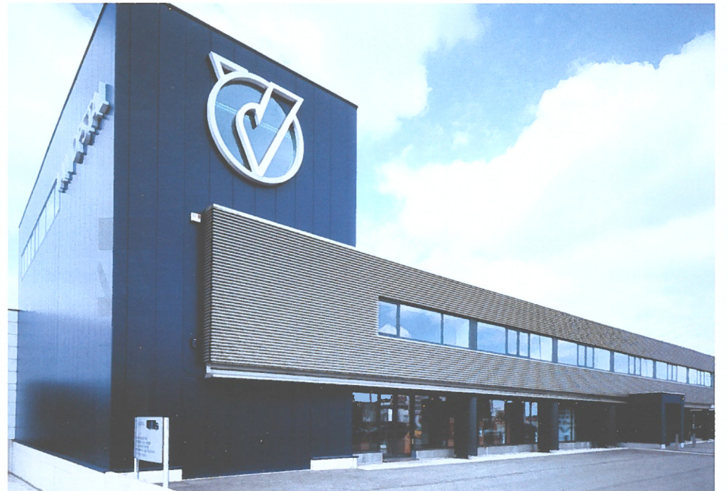
Hoofdkantoor van de groothandel voor meubelbeslag Van Opstal in Aartselaar met ruime showroom.
